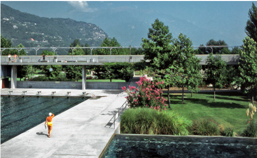
Figure 12 - Vue longitudinale sur la passerelle côté bassins
